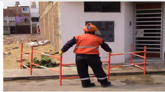
Instalación del cerco de seguridad
