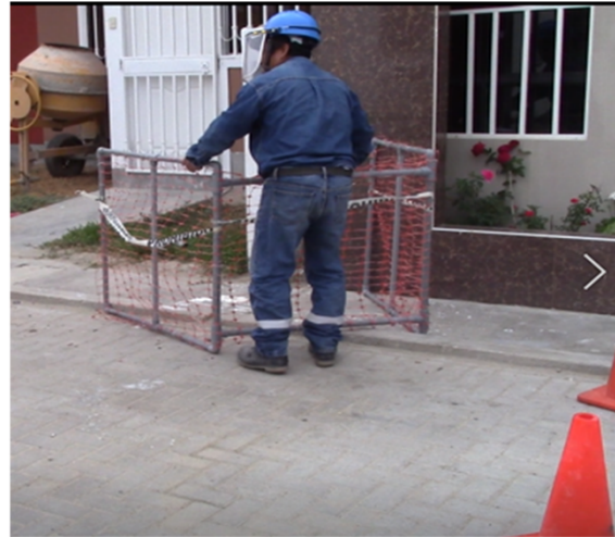
Instalación del cerco de seguridad
