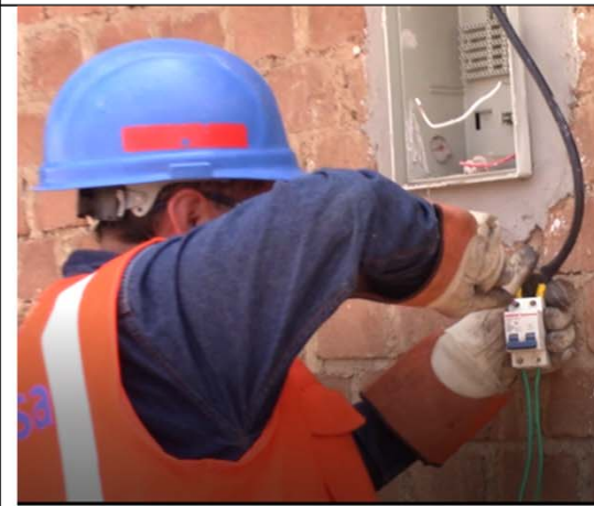
Instalación del interruptor termo magnético
