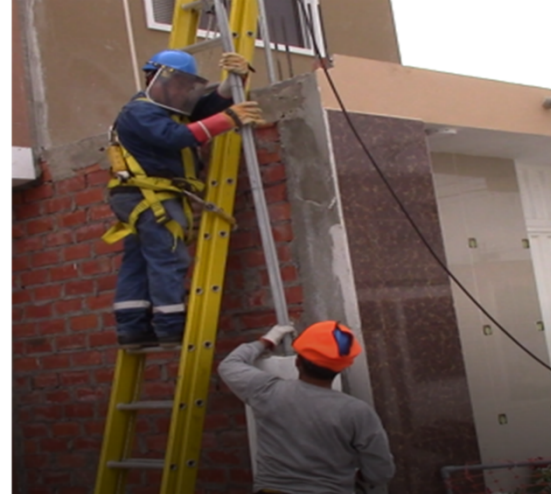
Fijación del tubo al murete
