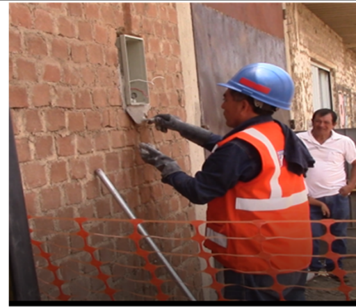
Fijación caja portamedidor
