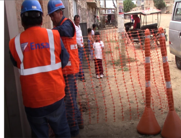
Instalación del cerco de seguridad
