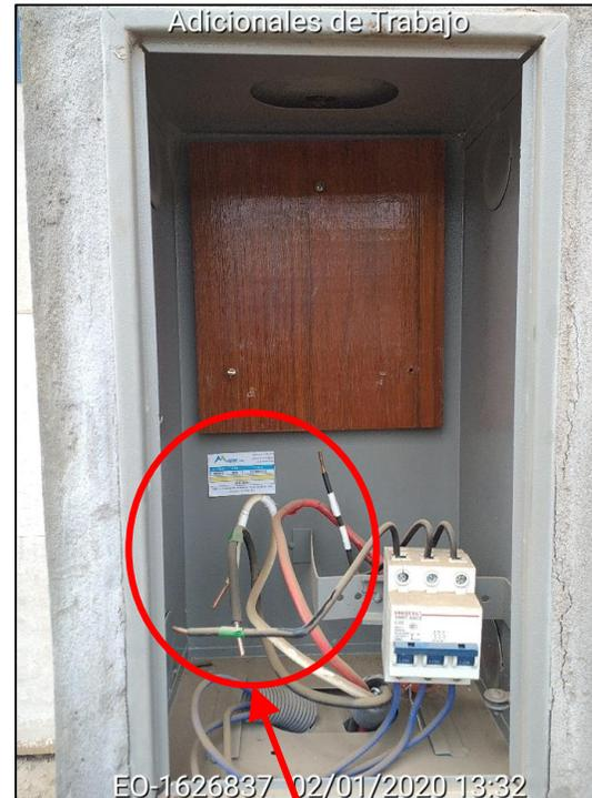
Parte energizada expuesta, en terminales de cable de acometida
