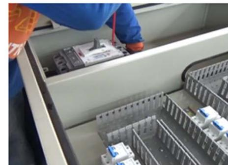
**3. Colocar ITM trifásico (360 amp) con las pletinas a la base tipo omega**
