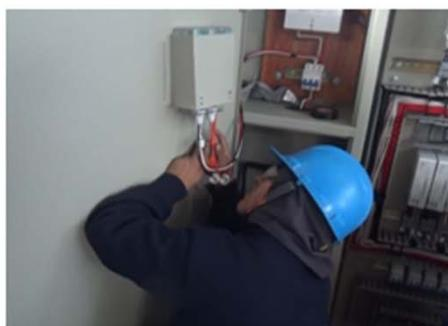
**10. Conectar el ITM trifásico (32amp) con el cable para visualizador**
