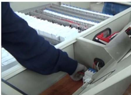
**7. Colocar y conectar ITM trifásico (32 amp) en la caja de tablero con las pletinas superiores**
