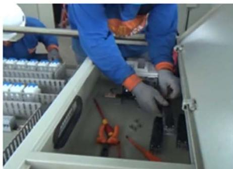
**4. Conectar las barras de derivación a las pletinas superiores.**
