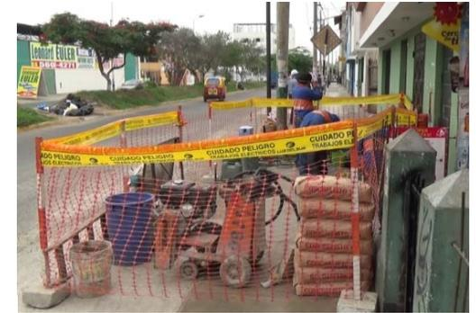
Materiales, herramientas y elementos de señalización utilizados para una conexión.
