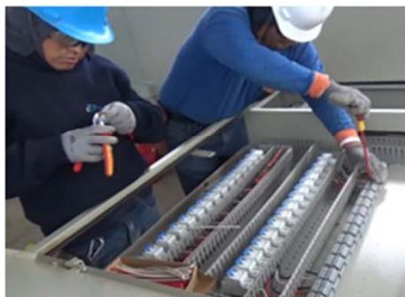
**5. Conectar las borneras inf. y sup. con ITM monofásicos sup. e inf. respectivamente.**
