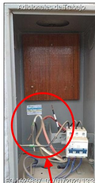
Parte energizada expuesta, en terminales de cable de acometida
