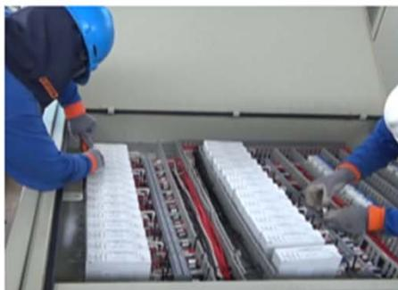
**8. Colocar, fijar y conectar los módulos de medida con borneras**
