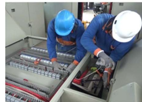
**6. Conectar las barras de derivación con borneras superiores**
