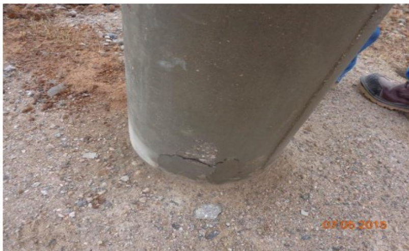
Estructuras de concreto corroídas en la base
